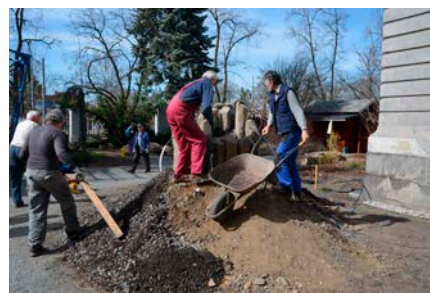
Dokončení vrcholové palisády
